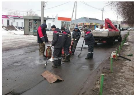
Сотрудники бригады по благоустройству следили за состоянием дорог в деревне Горбунки. Талая вода очень быстро разрушает асфальт. Из-за наледи вода плохо уходит, образуя лужи. Малейшая трещина — и машины брызгами воды разбивают и раскидывают дорожный материал. Ямы заделали на съезде с шоссе к университету. Также было заделано 15 ям разного размера, на дистанции от дома № 16 до дома № 10.
