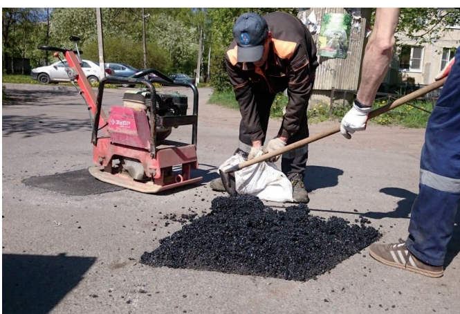
В Горбунках бригада по благоустройству произвела локальный ремонт асфальтового покрытия.
