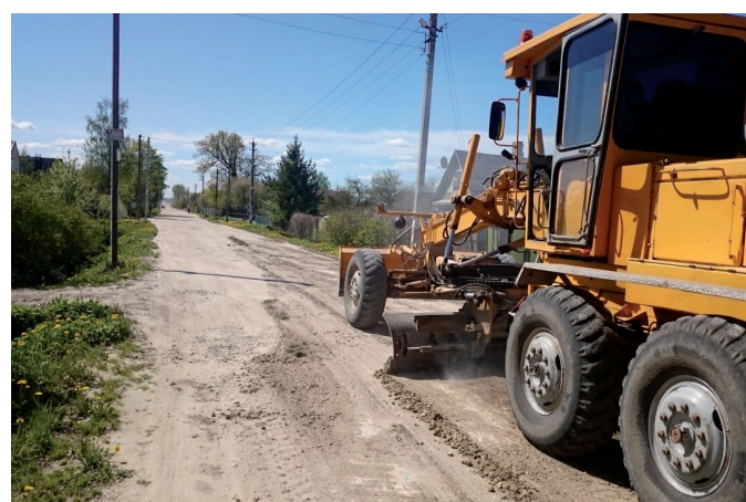
В ряде населённых пунктов велись дорожные работы. В частности, на дорогах с грунтовым покрытием выравнивали проезжую часть.
