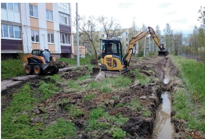
Благоустройство подтопляемой территории между домами № 50 и 52 в Горбунках. В настоящее время закончена прокладка дренажного хода для сброса грунтовых вод. Все работы по изысканию, проектированию и монтажу произведены силами бригады по благоустройству. Большое количество существующих подземных коммуникаций
